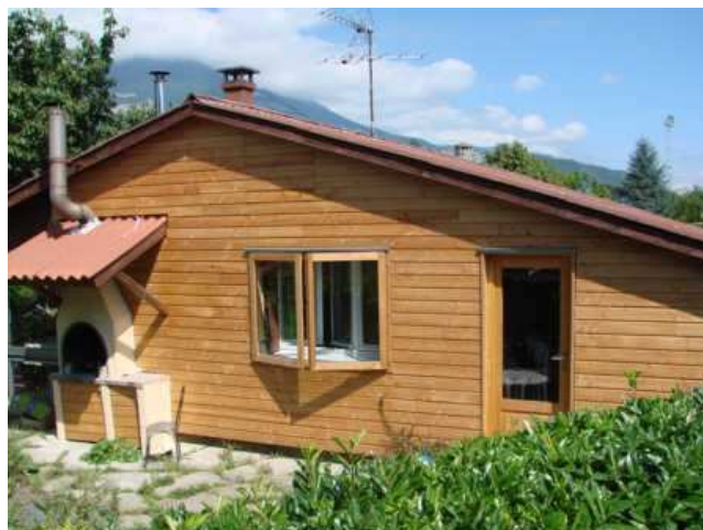
Vue Sud après Tranche 1
