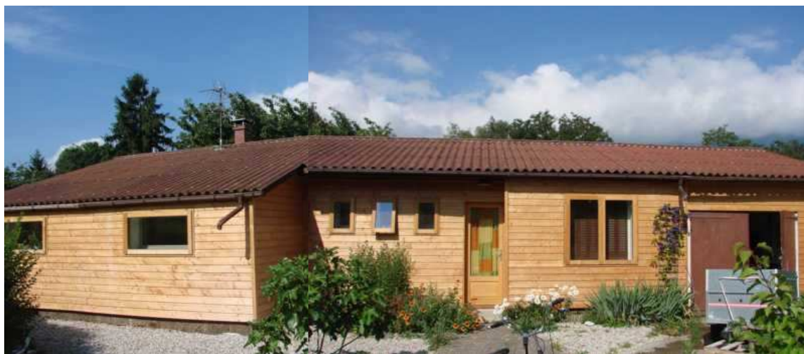
Vue Est après Tranche 1
