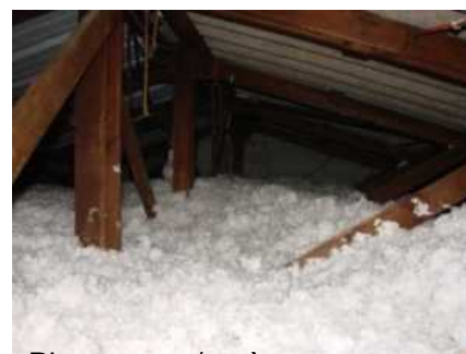
Photo avant/après travaux
