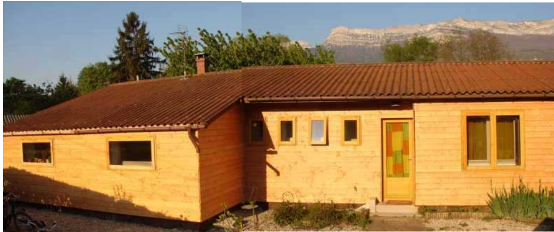
Vue Est après Tranche 1
