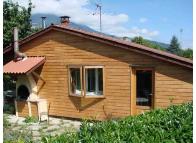
Vue Sud après Tranche 1
