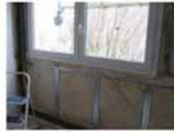
4 - Pose de l'isolant
