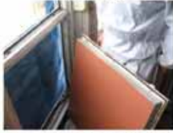
1 - Dépose de l'ancien panneau intérieur amianté
