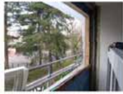
3 - Pose de la nouvelle menuiserie
