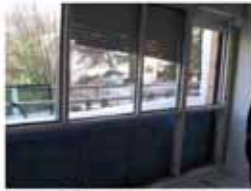
2 - Dépose ancienne menuiserie
